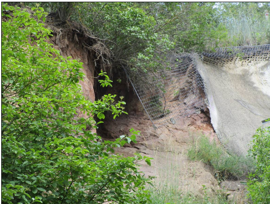
Obr. č. 21 – detail místa odkud došlo k řícení, na snímku je patrná síť a zbytek torkretu, který ovšem nezabránil pádu skalních bloků
