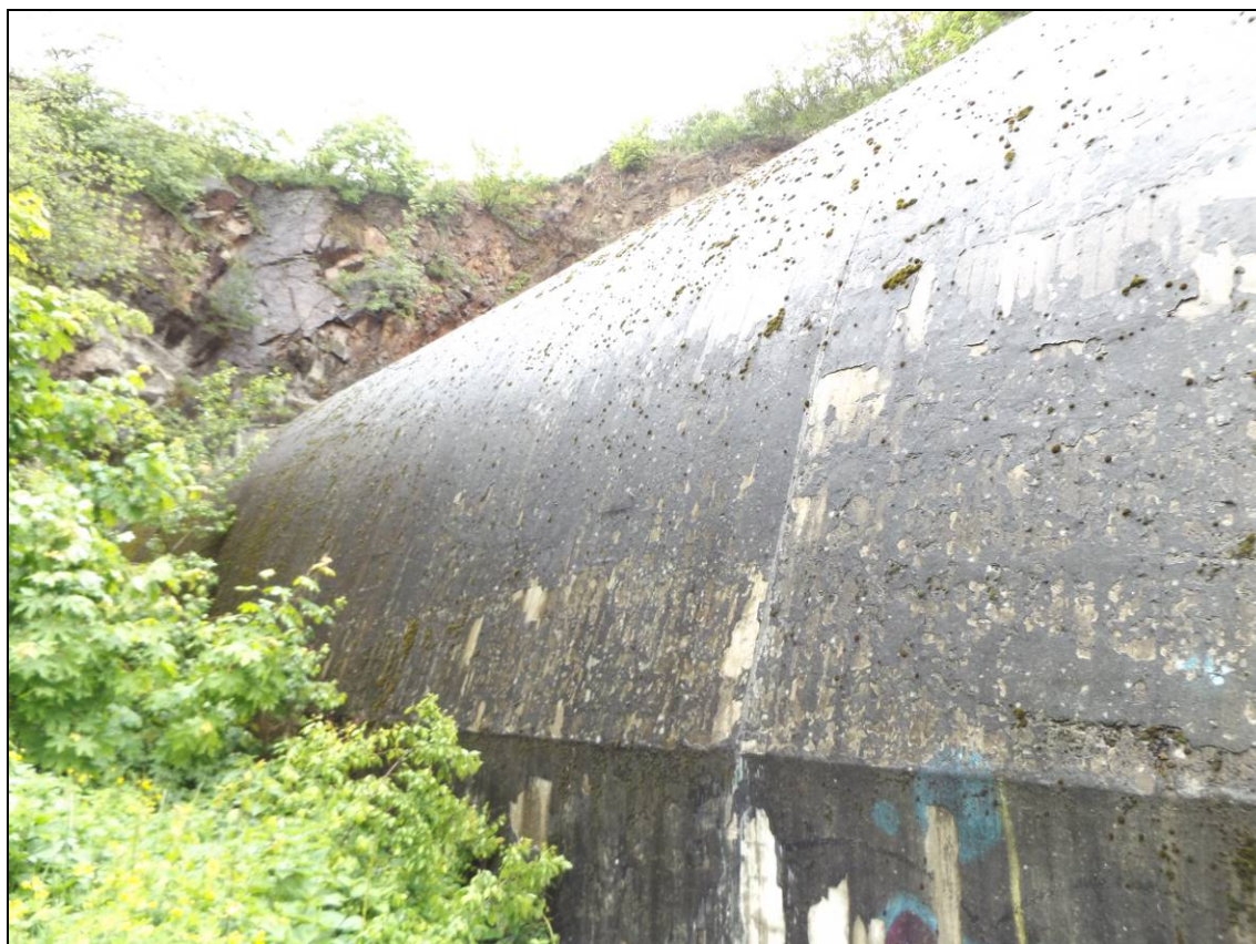
Obr. č. 19 – pohled na opady omítky v lici výjezdového portálu P2 na pravé straně
