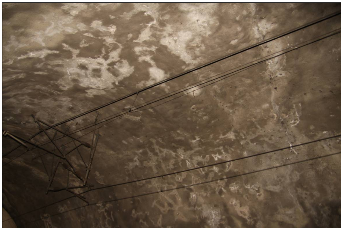
Obr. č. 14 – pohled na líc klenby tunelového pásu č. 3 - skupiny všesměrných vlasových trhlin v ostění, dlouhodobé plošné a bodové průsaky vlevo i vpravo nad kolejí č. 1 a 2, které jsou doprovázeny tvorbou vápenných usazenin
