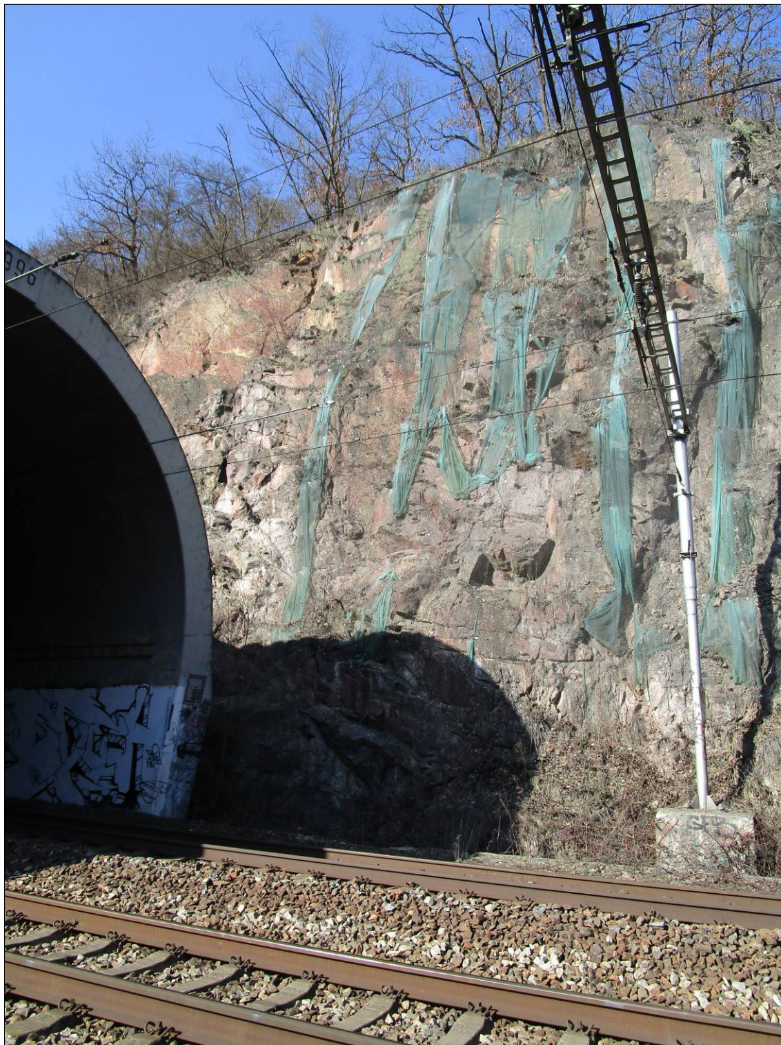
Obr. č. 23 – skalní stěna u výjezdového portálu o výšce cca 15 m, zakrytá sítí přichycenou hřeby (pravděpodobně zbytky provizorního zajištění při rekonstrukci v roce 1996)
