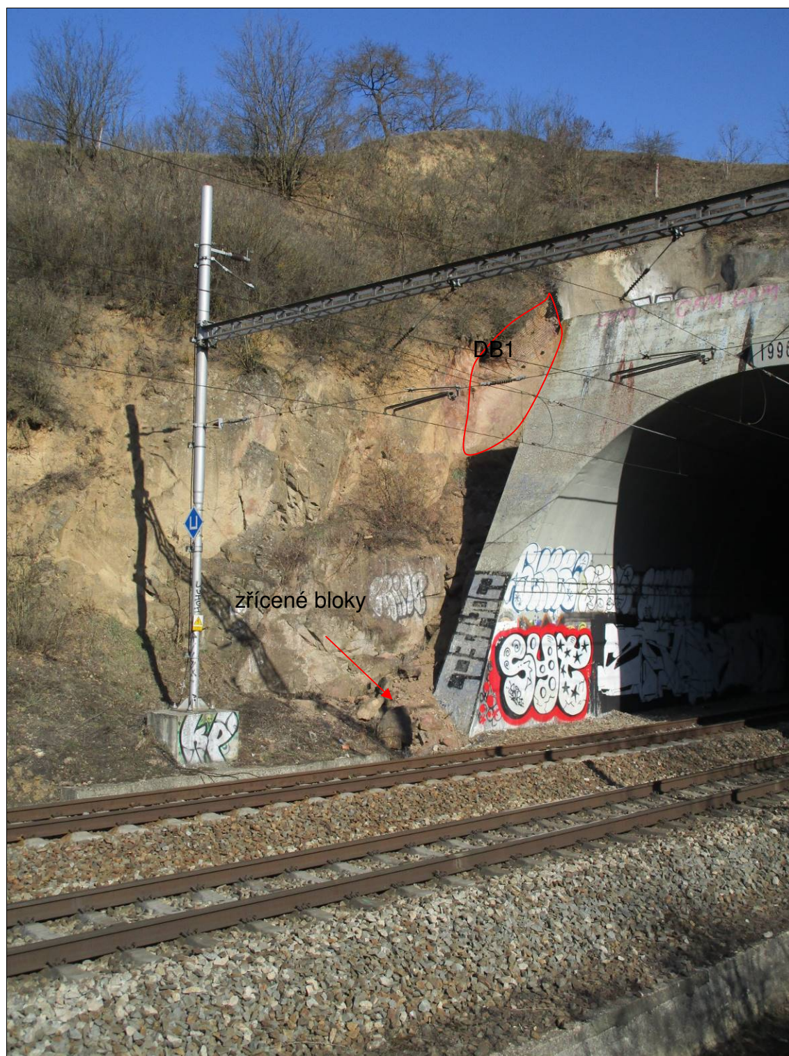
Obr. č. 20 – skalní stěna u vjezdového portálu, červeně je označeno místo u horní hrany svahu odkud došlo k pádu skalních bloků, u paty stěny jsou zřícené bloky; DB1- dokumentační bod
