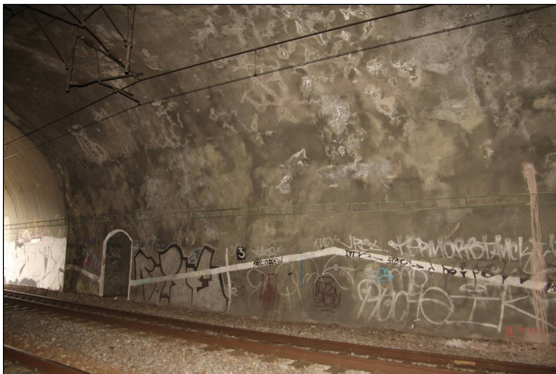
Obr. č. 13 – pohled na líc tunelového pásu č. 3 a 2 - skupiny všesměrných vlasových trhlin v ostění, dlouhodobé plošné a bodové průsaky vlevo nad kolejí č. 1, které jsou doprovázeny tvorbou vápenných usazenin
