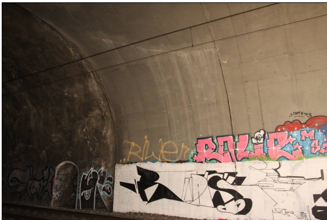
Obr. č. 11 – pohled na líc tunelového pásu č.1 - podélná trhlina vpravo nad kolejí č. 2
