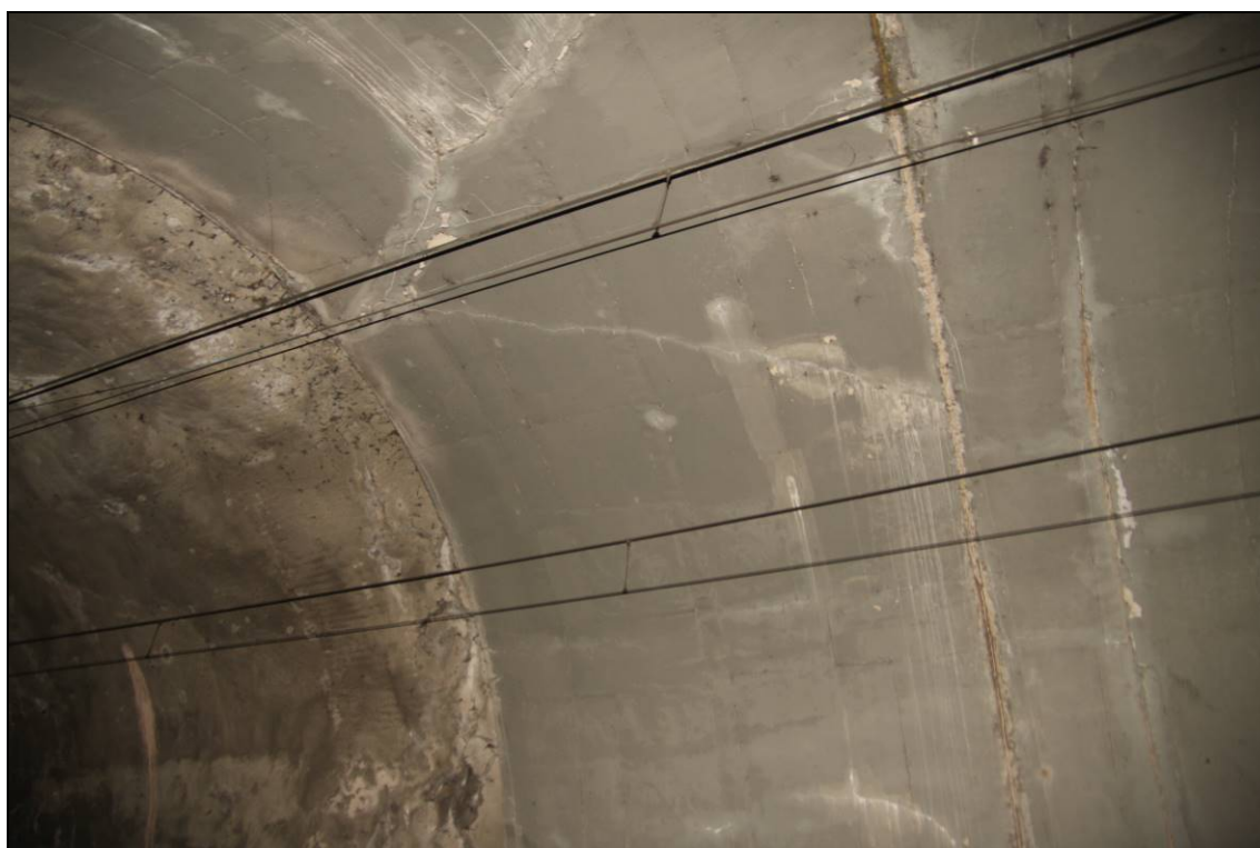
Obr. č. 16 – pohled na líc klenby tunelového pasu č. 5 - trhliny v klenbě nad kolejí č.1 a 2
