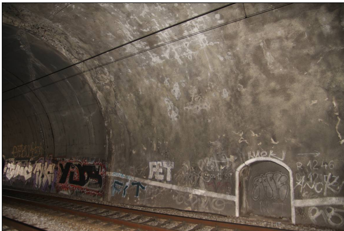
Obr. č. 15 – pohled na líc tunelového pásu č.4 - dlouhodobé plošné a bodové průsaky vpravo nad kolejí č. 1
