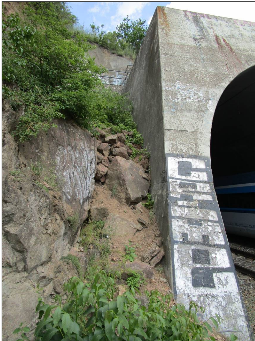
Obr. č. 22 – detail místa zřícených skalních bloků
