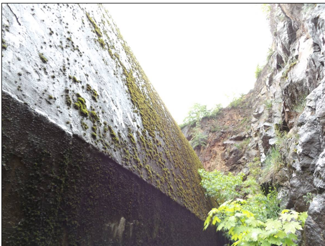
Obr. č. 20 – pohled na levou stranu výjezdového portálu P2 porostlého mechy
