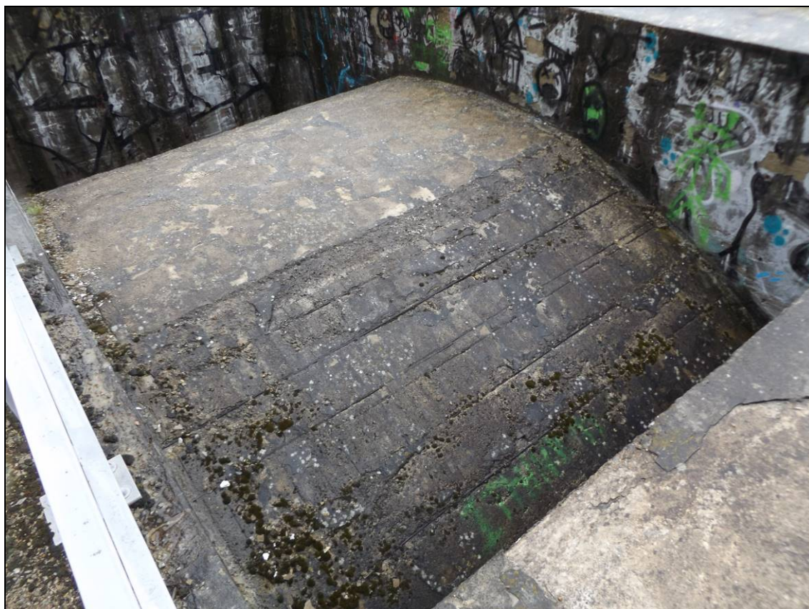
Obr. č. 9 – Pohled na líc tunelového pásu s odkrytou podélnou rozdělovací výztuží
